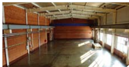
Цеха перед установкой оборудования
