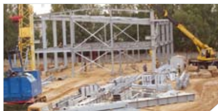
Начало строительства. 2006 год
