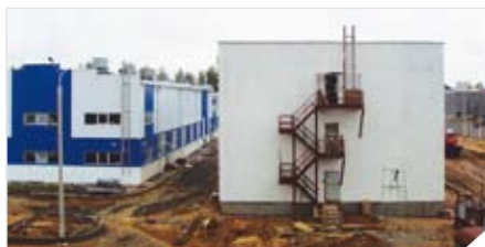
Завершение строительства. 2007 год
